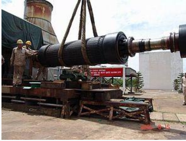
Hình 10.7. Rotor của một máy phát điện tua bin khí sau khi được rút ra ngoài, và chuẩn bị cẩu về cơ xưởng
