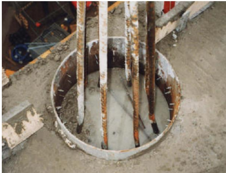
Hình 4.2 Bê tông nhồi ống thép có các đinh Hinti tạo liên kết
