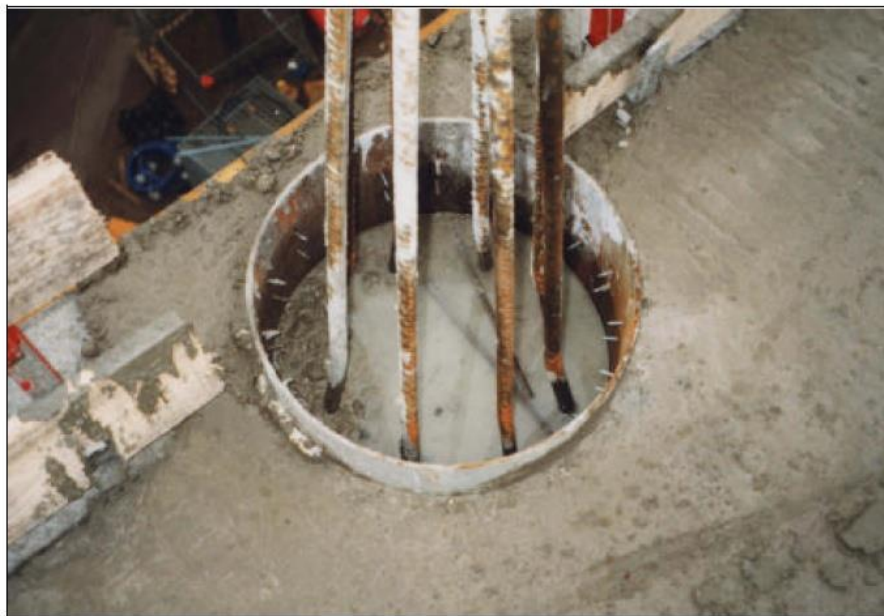
Hình 1.13 Cột ống thép nhồi bê tông có gắn các đinh Hinti
