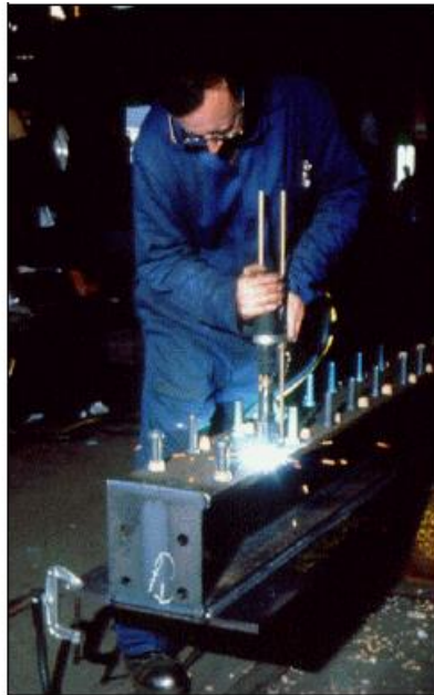
Hình 1.10 Hàn các chốt mũ cho dầm trong nhà máy
