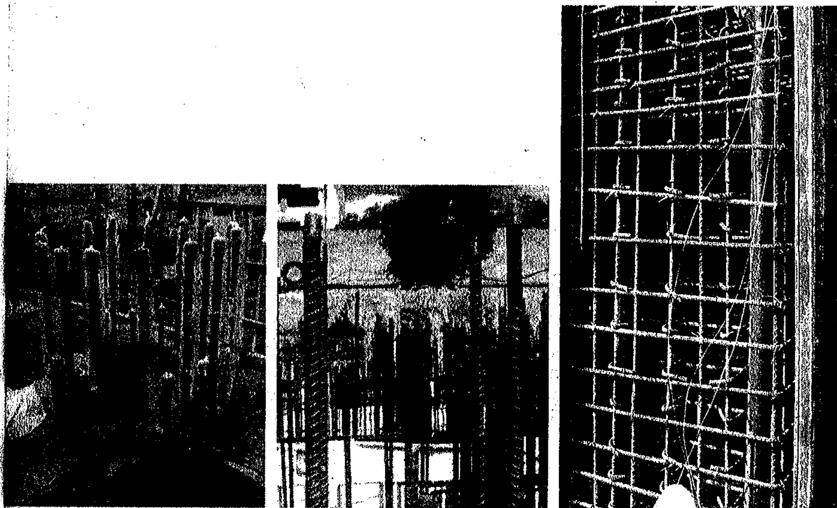
Hình 2.54 Nối bằng coupler
