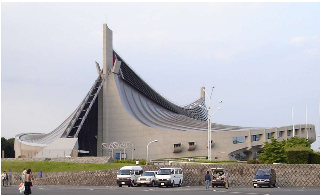
Hình 27: Kết cấu dây treo - Nhà thi đấu Yoyogi Gymnasium Nhật Bản
