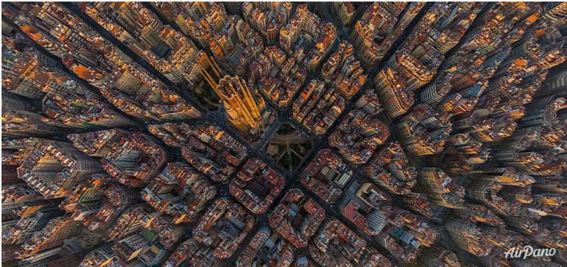
Hình 8: Quy hoạch mạng lưới giao thông ô cò có đường chéo của thành phố Barcelona – Tây Ban Nha
