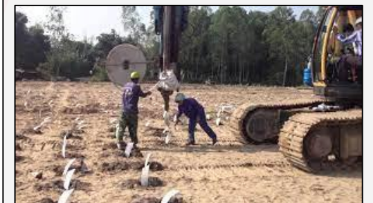
Hình 5.5. Cấu tạo máy ép cọc bắc thẩm
