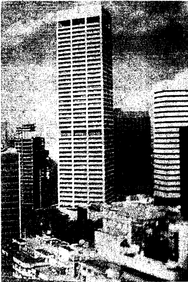
Hình 4.119 : Nhà cao tầng xây theo phương pháp copfa trượt
