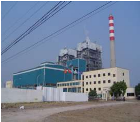
Hình 4. Nhà máy nhiệt điện Cao Ngạn - Thái Nguyên
